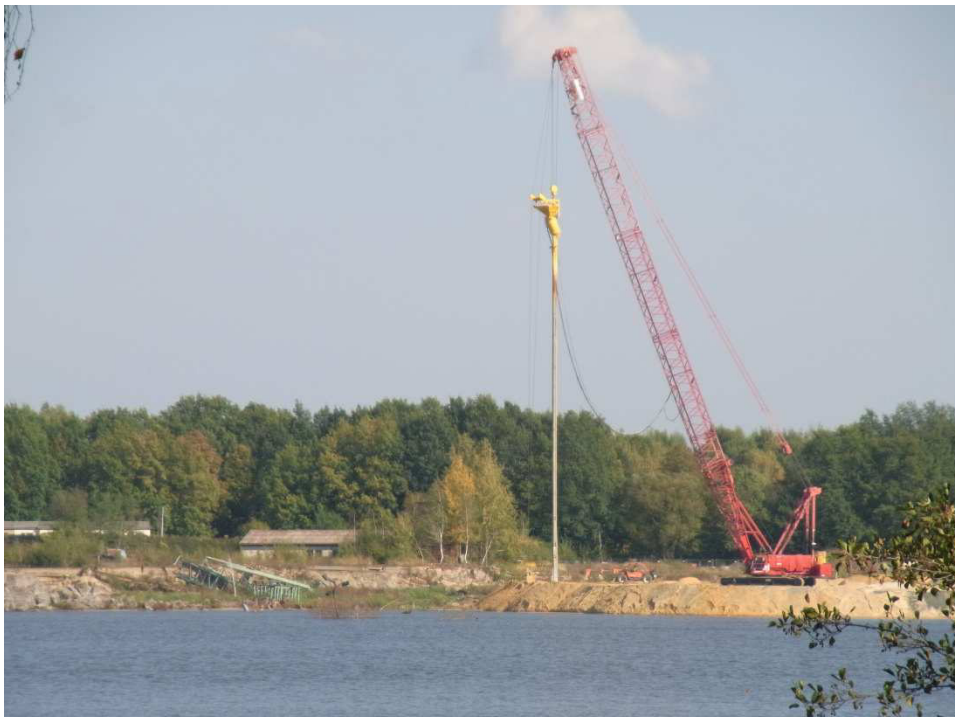
Rüttelstopfverdichtung, Fa. Keller Grundbau GmbH, Seilbagger mit ausgefahrener Lanze und Füllschacht Ort: Silbersee/Tgb. Werminghoff II/Lohsa 1/Sachsen Quelle: Copyright: M. Lersow; Tag der Aufnahme: 12.10.2012
