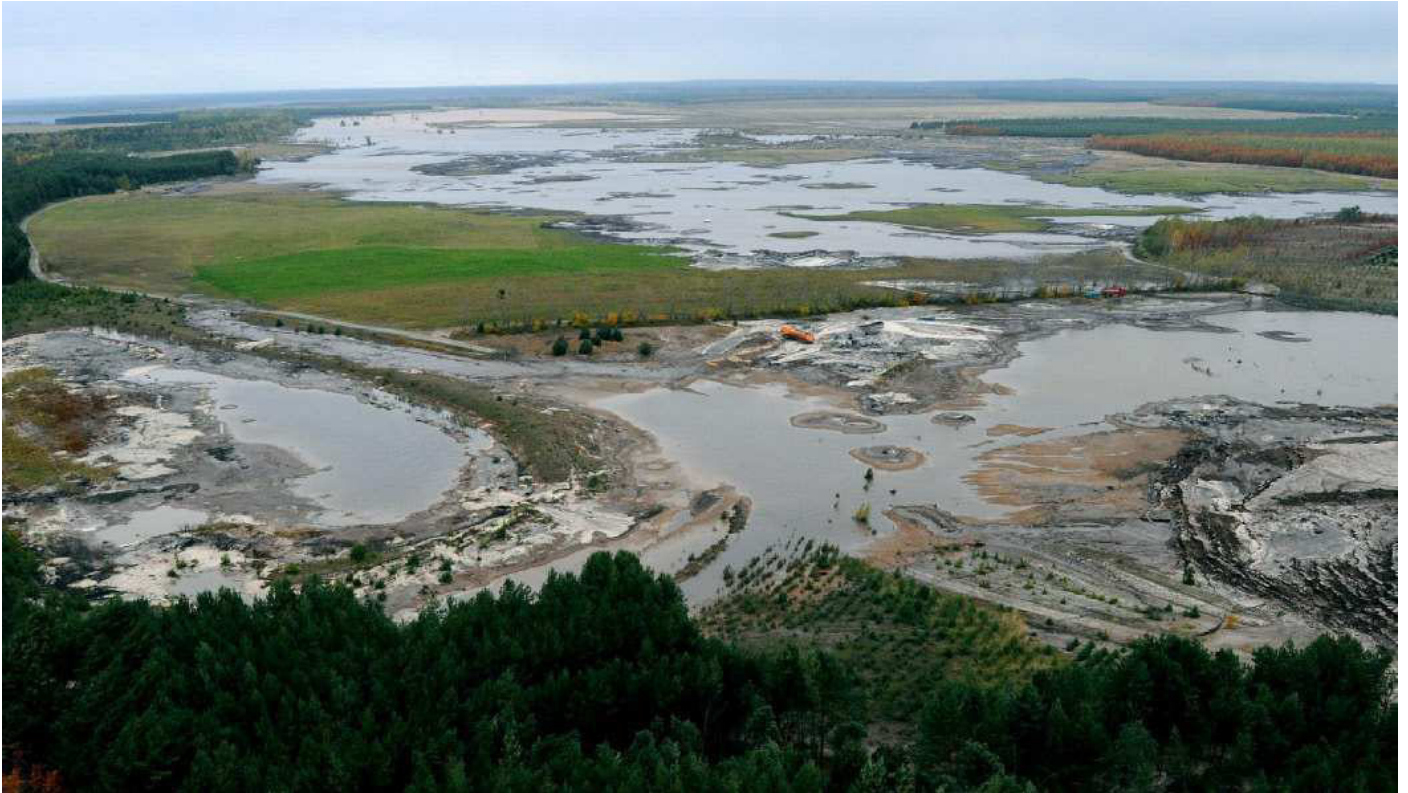
Versagen eines 160 ha großen Areals durch Grundbruch eines Innenkippenareals; Ort: Spreetal-Sachsen Quelle: Peter Radtke, LMBV mbH , aufgenommen am 21.10.2010
