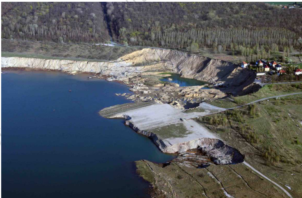
Kollabiertes Nachterstedter Böschungssystem, Vordergrund: Reste der Slipanlage; Hintergrund: Verunfallte Siedlung „Am Ring“ Quelle: Copyright: M. Lersow; Tag der Aufnahme: 13.04.2010
